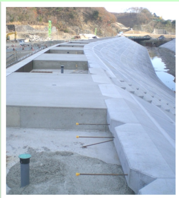
点検孔設置状況
