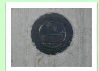
点検孔設置完了 (生コン打設後)
