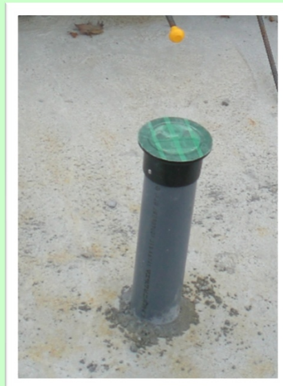
点検孔設置状況 (生コン打設前)
