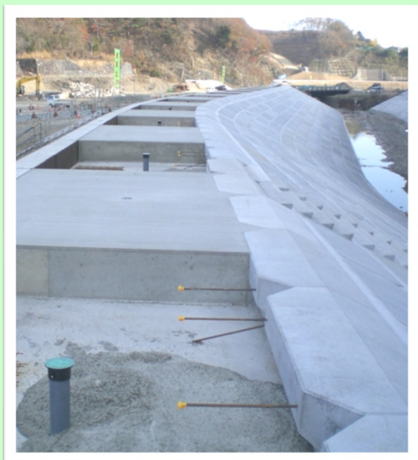
点検孔設置状況
