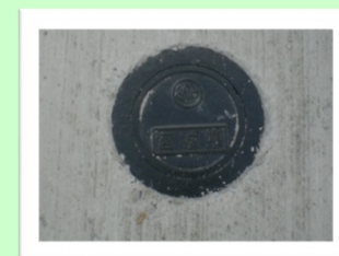
点検孔設置完了 (生コン打設後)
