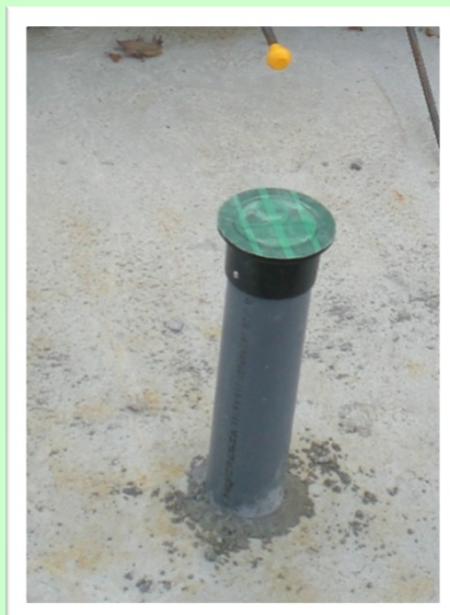
点検孔設置状況 (生コン打設前)
