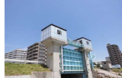
全面アルミ複合板 折半屋根
