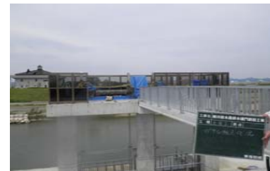
パネル組立(施工中)
