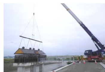
屋根吊り込み
