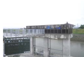
パネル組立(施工後)
