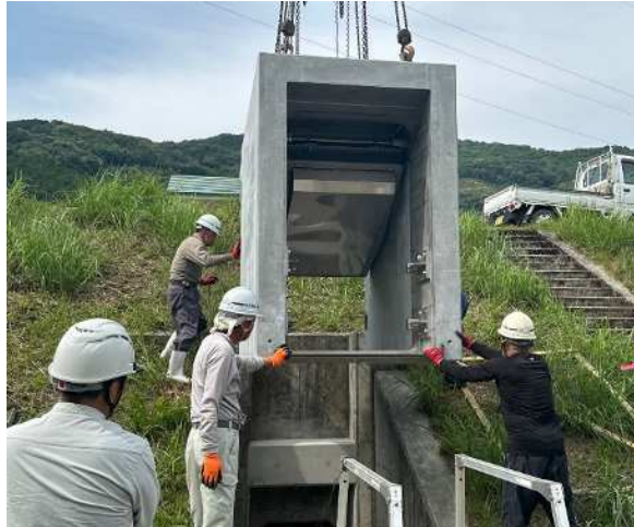
佐野川樋門(宮崎県延岡土木事務所) : 川裏
